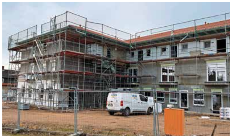
Der Bau des Ambulanten Quartiershauses schreitet voran.
