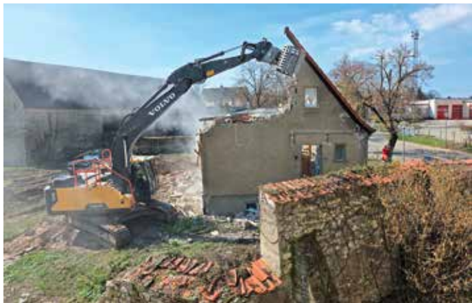
Stück für Stück wurde das abgängige Gebäude sicher abgetragen.
